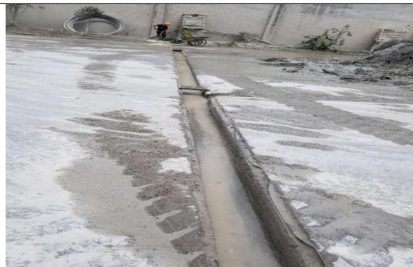
厂区内雨水沟
