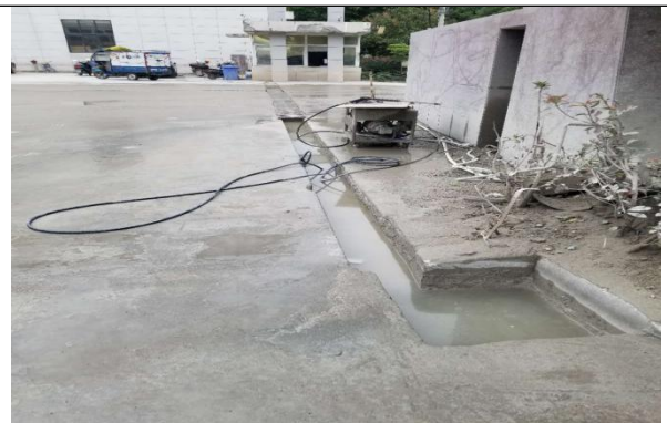
厂外截流沟和收集槽
