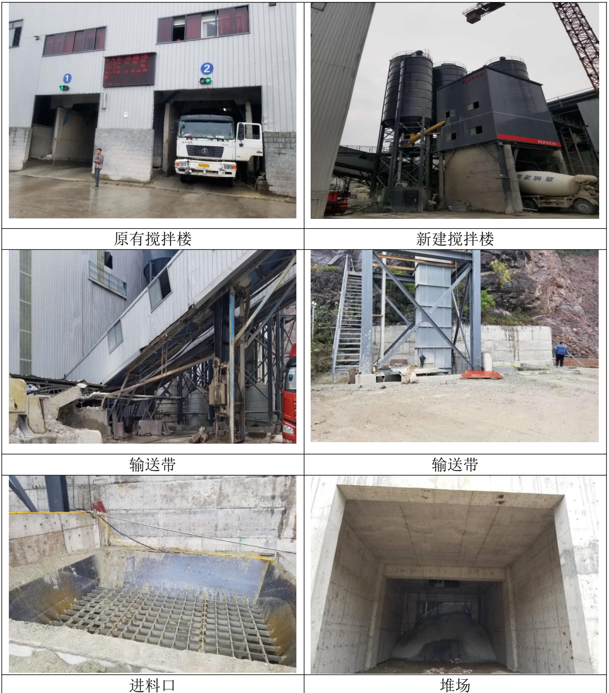
图 3-4 生产线废气产污结点现场图
