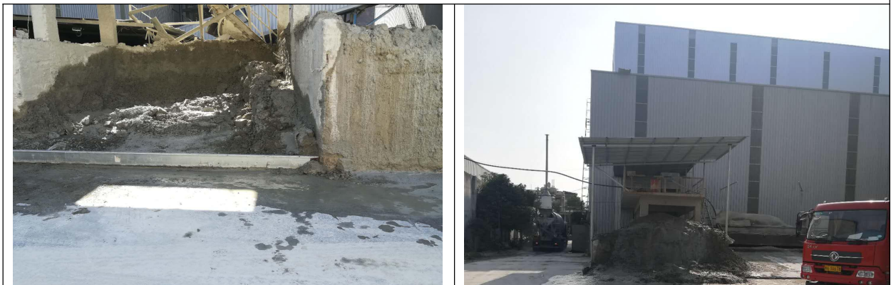
图 3-5 污泥房现场图
