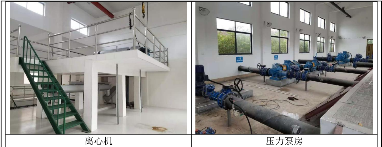
图 2-1 主要建（构）筑物现场图
