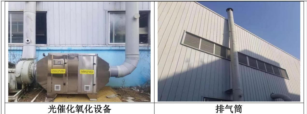
图 4-2 项目废气产污结点和处理设施现场图
