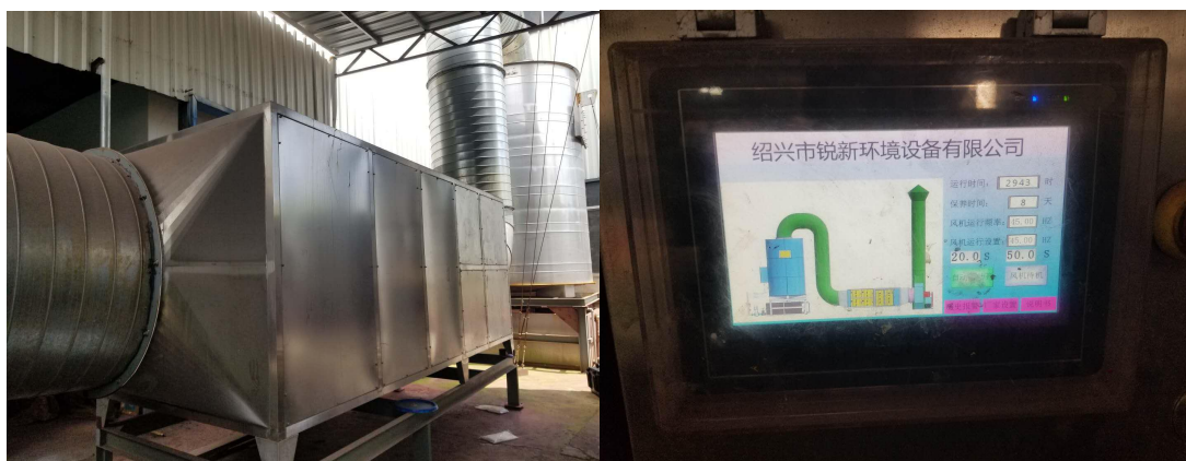
图 5-4 1#、2#喷漆处理设施现场图
