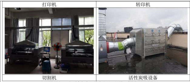
图 3-3 印刷废气产污结点和处理设施现场图
