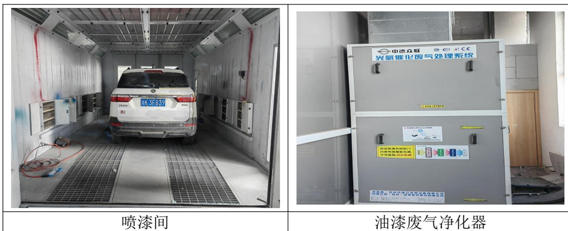
图 5.2-1 废气产污节点和处理设施现场图
