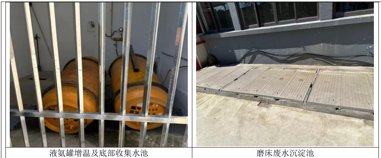
图 4-2 现场防治情况
