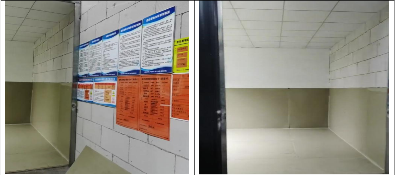
图 4-3 废物贮存间建设情况
