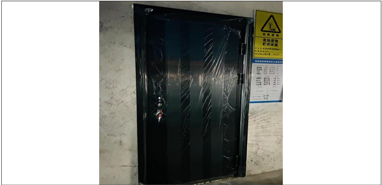
图 4-5 危废间建设情况
