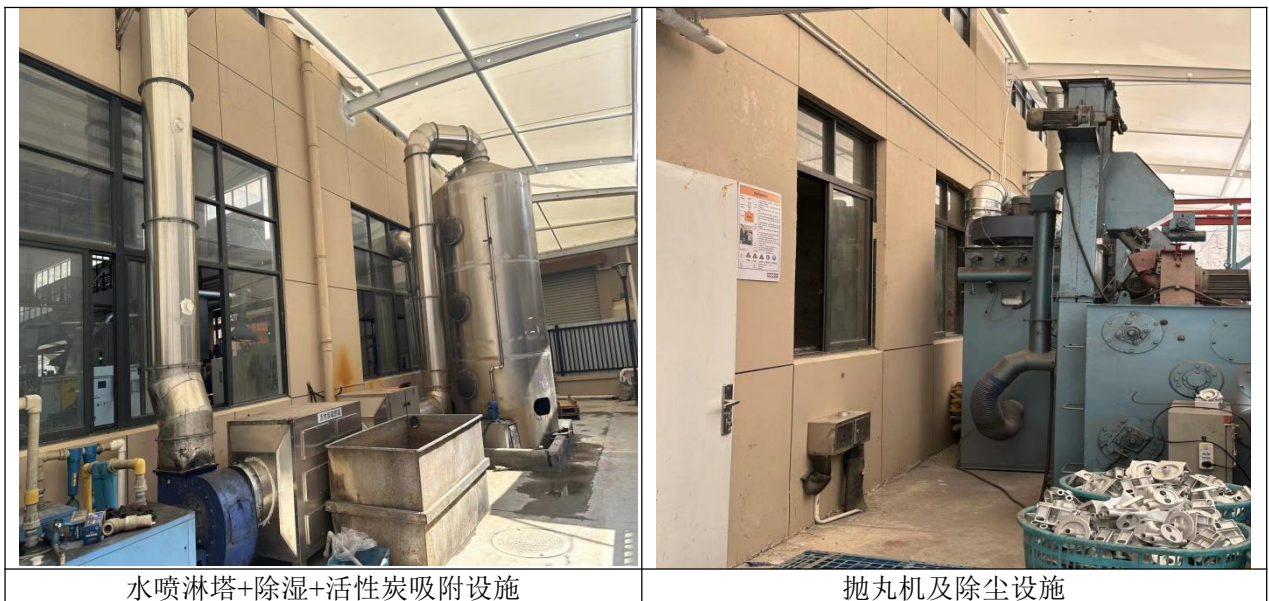
图 4-4 现场建设情况
